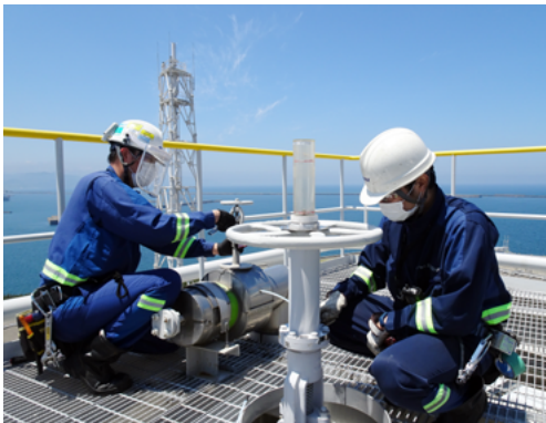
フェイスシールドとマスクを着用しての作業の様子 (直江津 LNG 基地)
